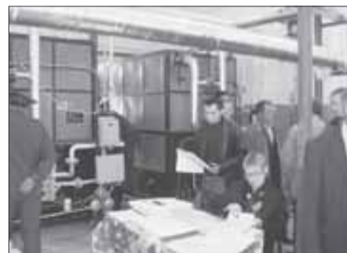
Приемка в эксплуатацию котельной в пгт Яр
