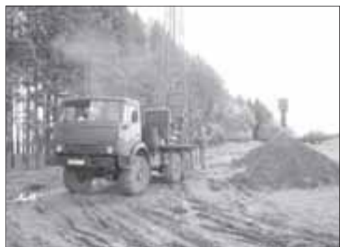
Бурение скважины на воду
