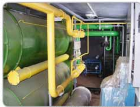
Монтаж импульсной котельной
