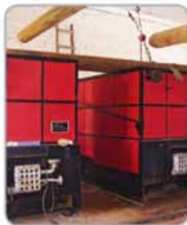
Монтаж котлов в гостиничной с. Грахово
